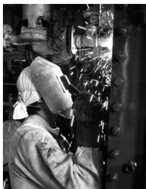
現場でのボイラー修理は被覆アーケ 溶接の技術が必要になる
