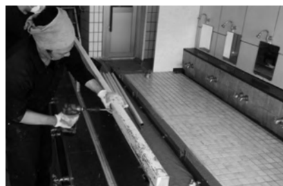
配管工事・シャワーの取付・ポンプ修理等 浴場に関する設備に幅広く対応
